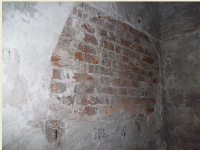
Saggio muratura Sm 4
