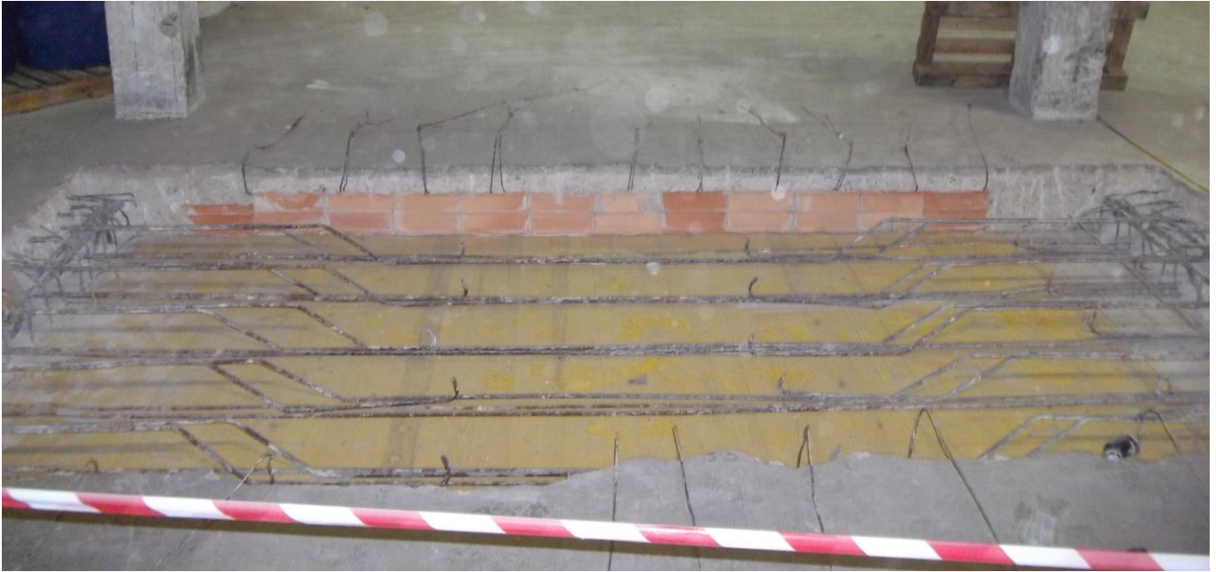
Armatura solaio
