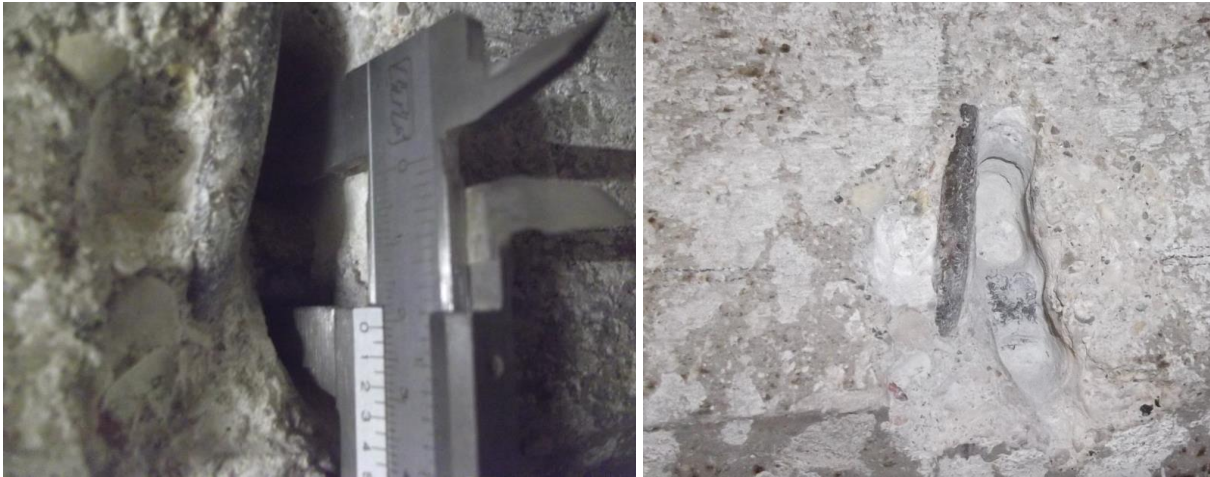
Armatura inferiore trave
