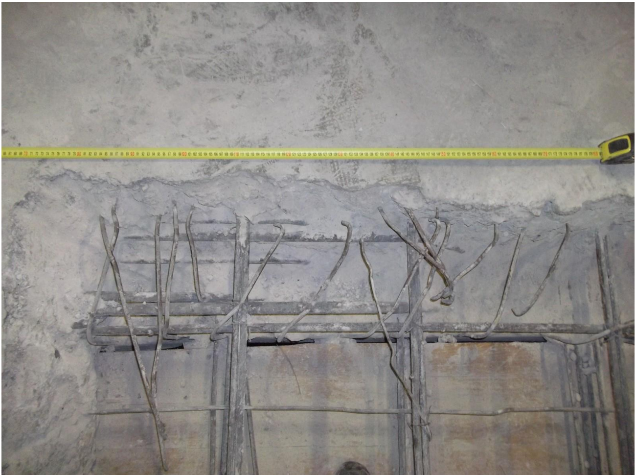
Armatura superiore trave
