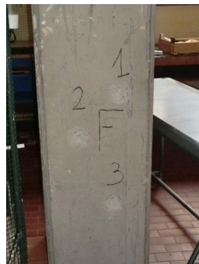
Pull out 5 e 6 rispettivamente nei pilastri P62 e P 84 del piano terra
