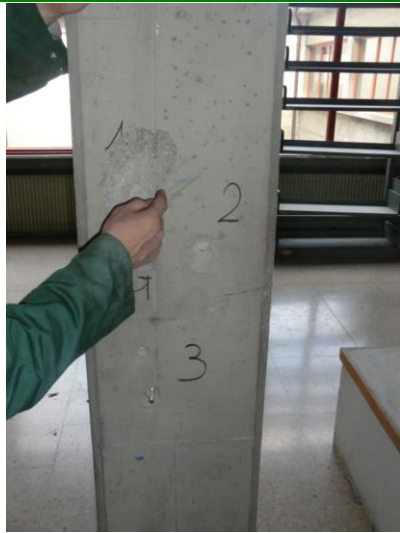
Pull out 7 e 8 rispettivamente nei pilastri P51 e P120 del piano primo e piano secondo
