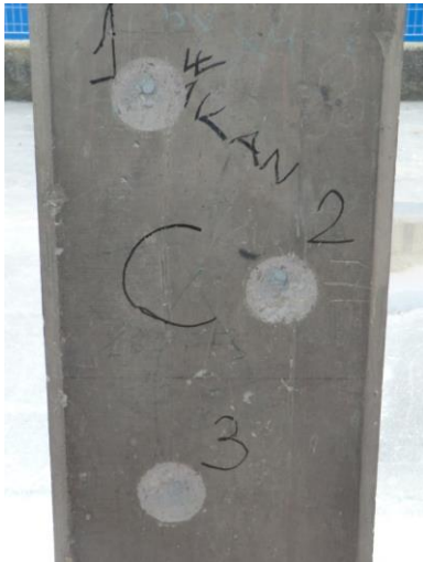
Pull out 3 e 4 rispettivamente nei pilastri P03 e P16 del piano terra
